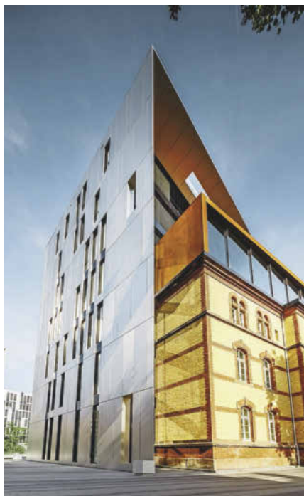
Die aufliegende Cortenstahlbox erweitert das alte Saarhaus um zwei Etagen.
