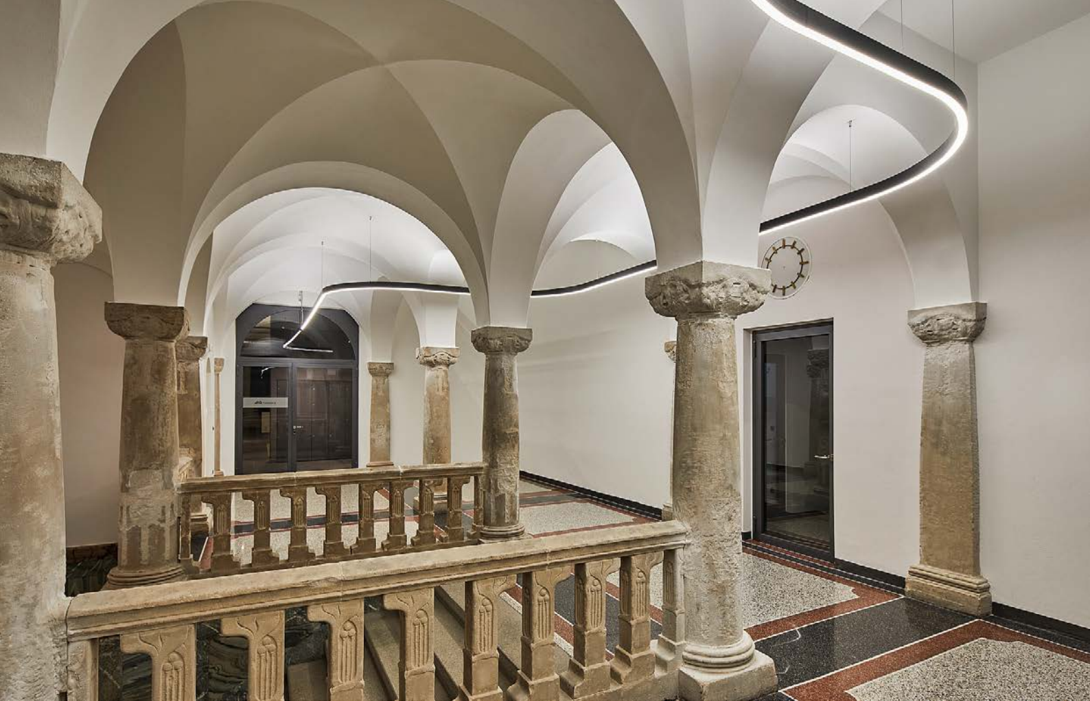
Abb.: Die schwebenden Linienleuchten haben eine imposante Spannweite von 4,5 Metern zwischen den Abhängepunkten in den Rundbögen. Sie bilden den Grundriss der Räumlichkeiten nach und setzen die Kreuzgewölbe gekonnt in Szene.
