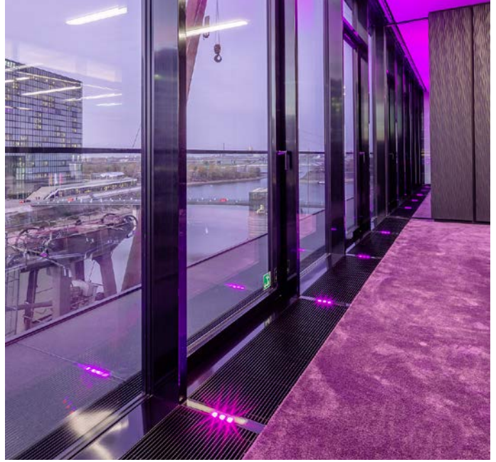
Abb.: Die hinter der Glasfassade liegenden Konvektorschächte wurden mit »LED-ConLights« kombiniert, die speziell für dieses Projekt entwickelt wurden.
