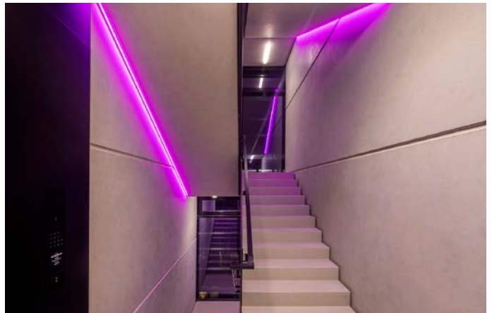
Abb.: Im Treppenhaus geben die Lichtlinien funktionales Licht zur Orientierung, erzeugen aber auch eine spielerische Komponente. Insgesamt wurden 47 lfm LED-Lichtlinie in 4.000 K verbaut.
