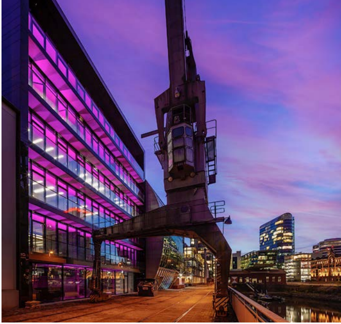
Abb.: Tagsüber gibt sich der monolithische Bau im angesagten Medienhafen zurückhaltend. Nach Einbruch der Dunkelheit kommt er aber voll zur Geltung und strahlt in Licht und Farbe.
