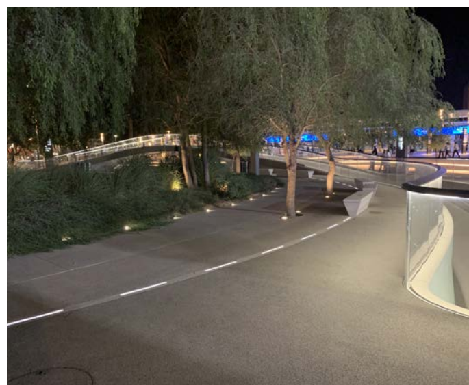
Abb.: Rund um den Pavillon wurden insgesamt 870 Lichtlinien vom Typ »LLF40.20« mit einer Länge von 620 Millimeter in den Boden verbaut.
