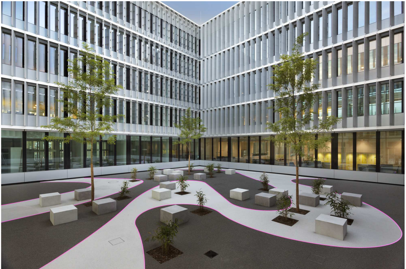
Die Lichtlinien von TTC Timmler schlängeln sich durch den Innenhof des Verwaltungsgebäudes. Foto © TTC Timmler
